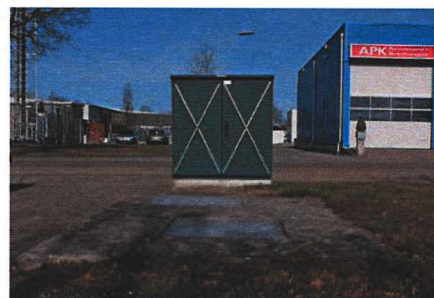
Bergbezinkbassin in middenberm
