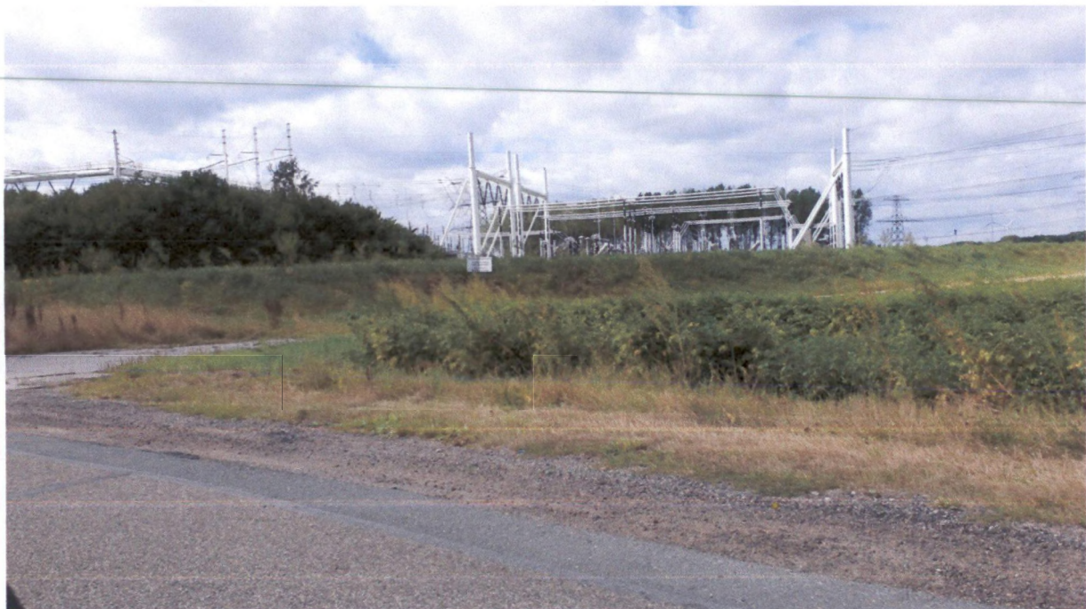
Figuur 2: Zicht op trafo station vanuit pand [REDACTED]
