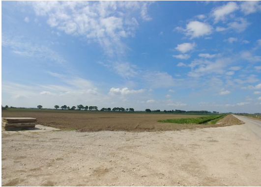
16 toegangspad windturbine in aanbouw
