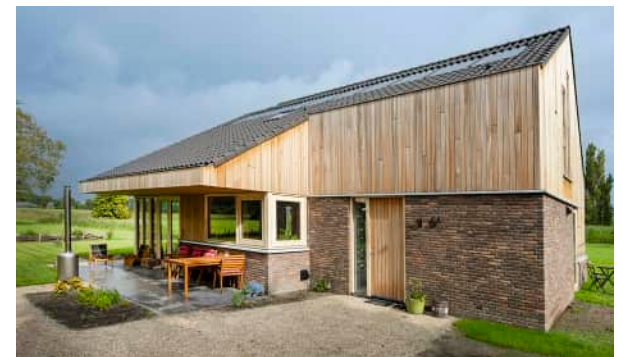
metselwerk in combinatie met houten delen
