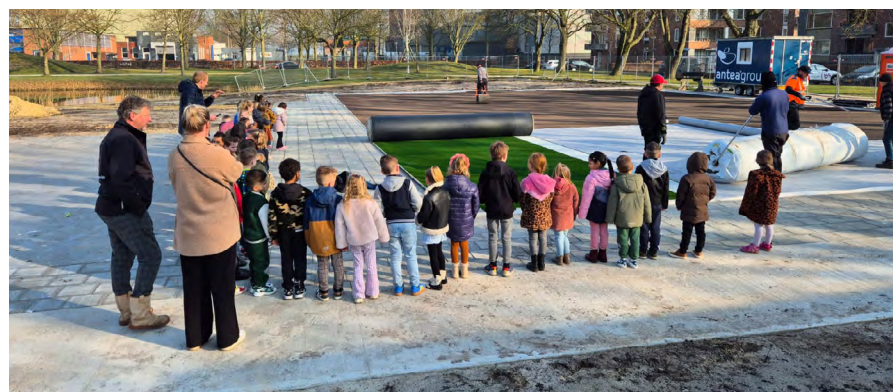
Kinderen waren op maandag 3 maart aanwezig bij de aanleg van het kunstgrasveld van het Cruyff Court Noorderpark.
